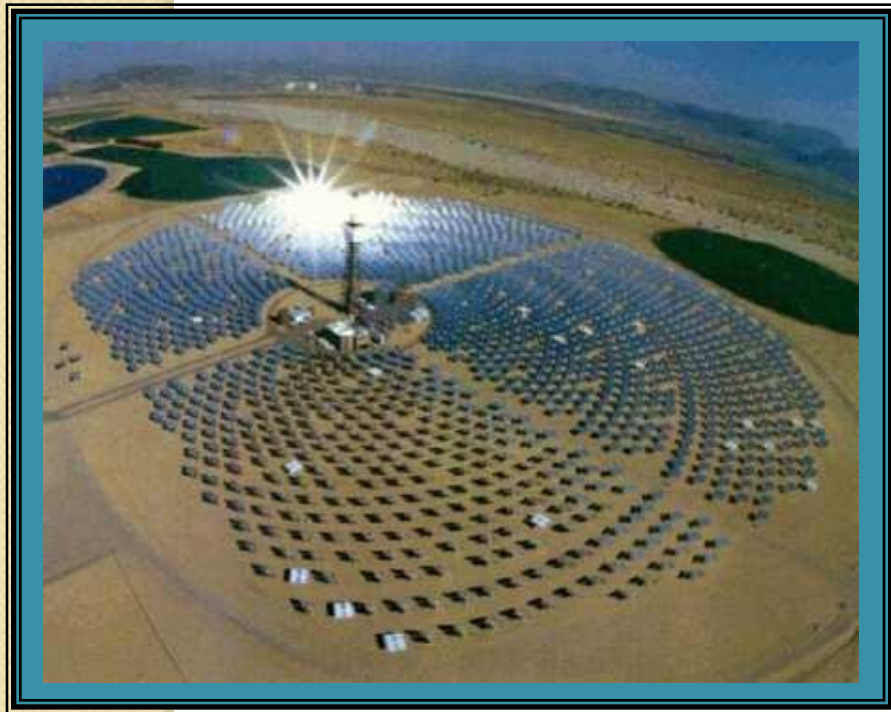
Солнечная электростанция (СЭС)
