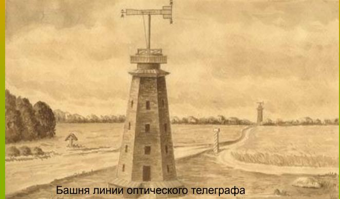
Ретрансляционная **станция семафорного телеграфа** конструкции французского изобретателя Пьера Шато.
