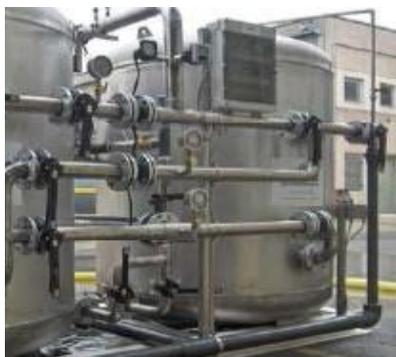
Модульный дизайн позволяет не прерывать подачу воды, в случае если одна часть блока остановится на техобслуживание или по другим причинам.
