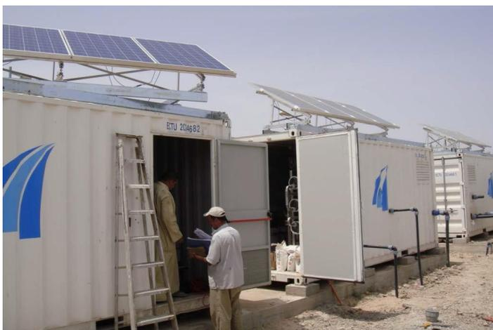
Компактные станции по очистке питьевой воды предназначены для производства безопасной питьевой воды из различных традиционных и нетрадиционных источников воды в зонах с ограниченными водными ресурсами и/или загрязненной водой.
