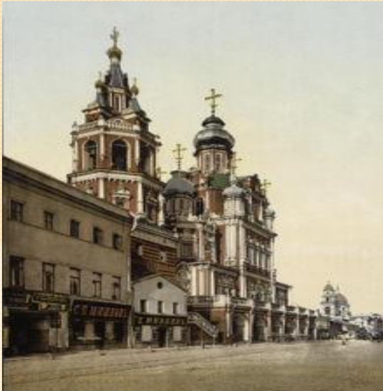
Церковь Успения на Покровке (1695 - 1699 гг.)
