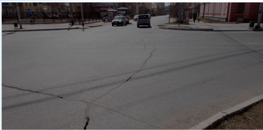
Морозобойные трещины
