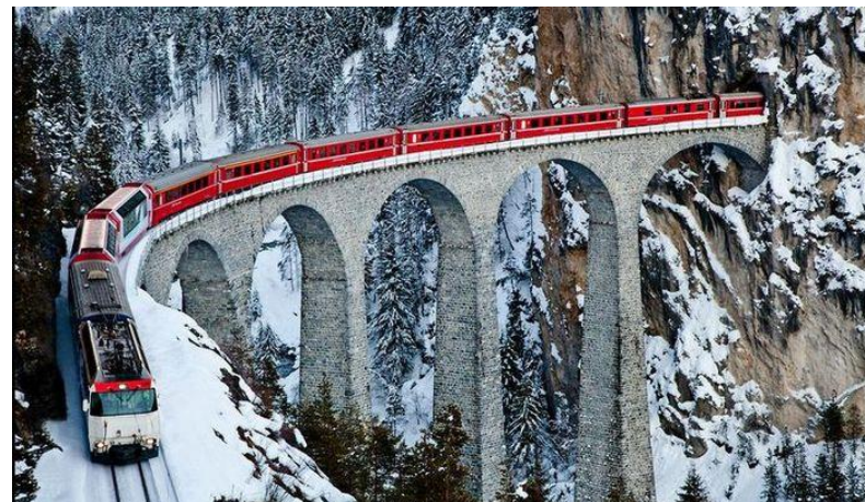
Швейцария железнодорожный мост h=65\text{м} и l=136\text{м}
