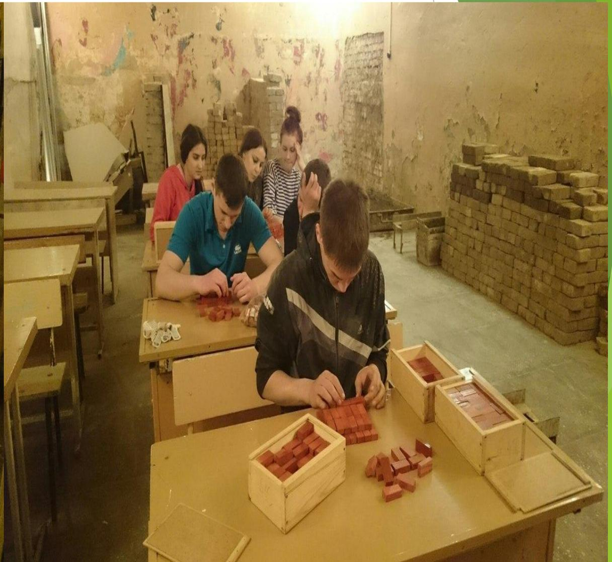
Однорядная кладка, пересечения стен
