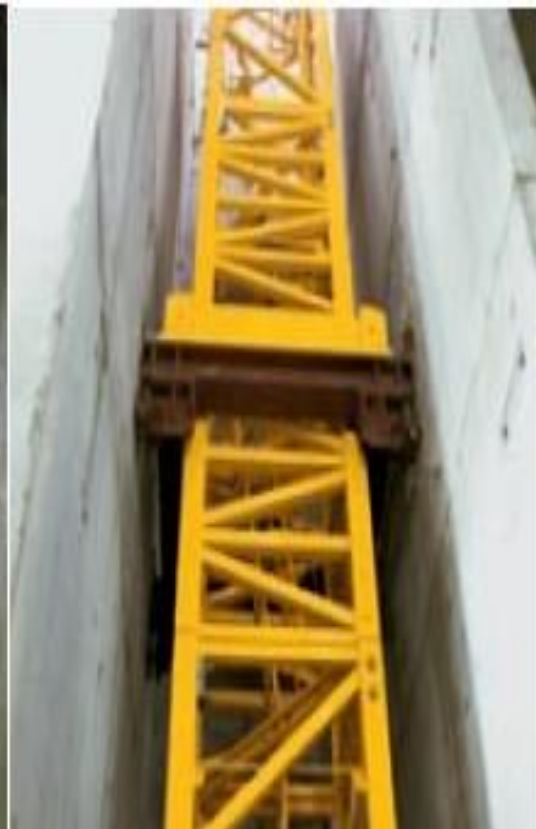
Крепление башни крана в лифтовой шахте
