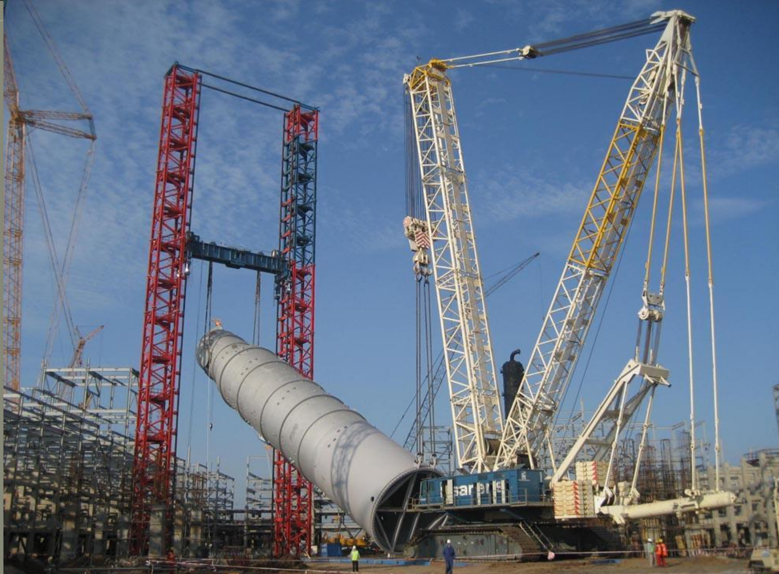
Монтаж секции трубы монтажной мачтой и вспомогательным краном Demag CC 8800
