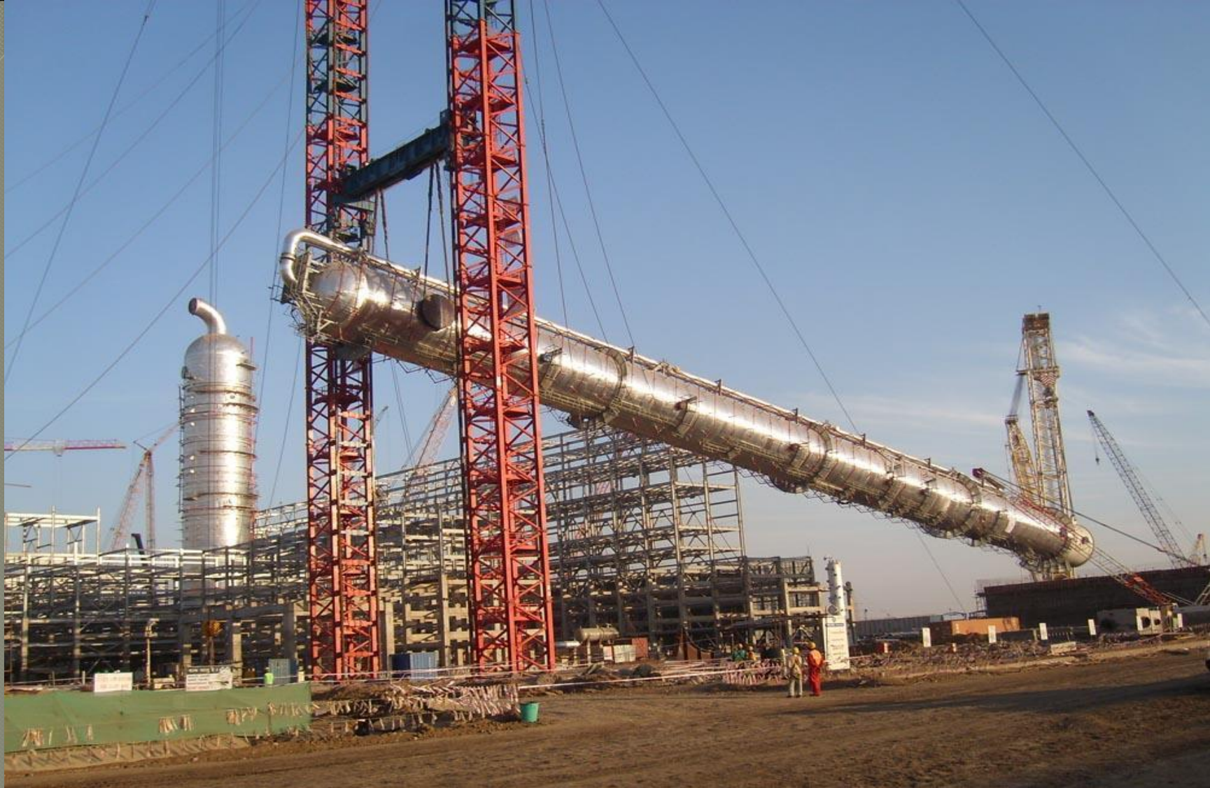
Монтаж нефтехимической колонны монтажной мачтой и вспомогательным краном
