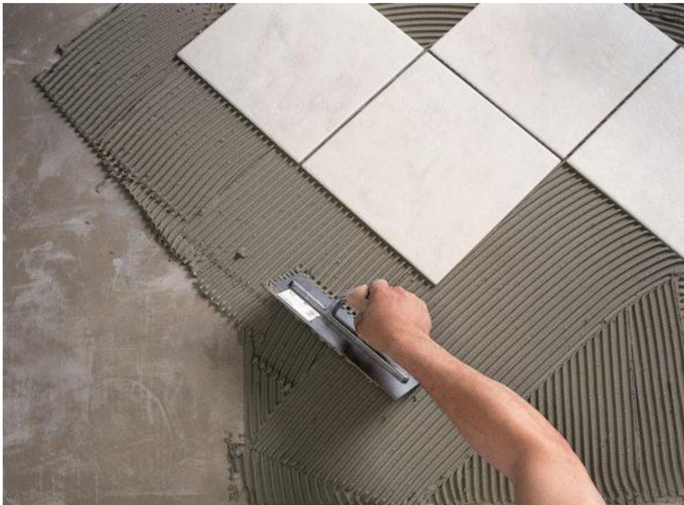
Укладывая, не забываем уровнем проверить горизонталь плитки
