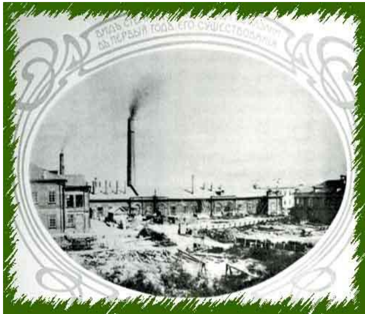
Завод Крестовниковых. 1853 Стеариново-мыльный завод
