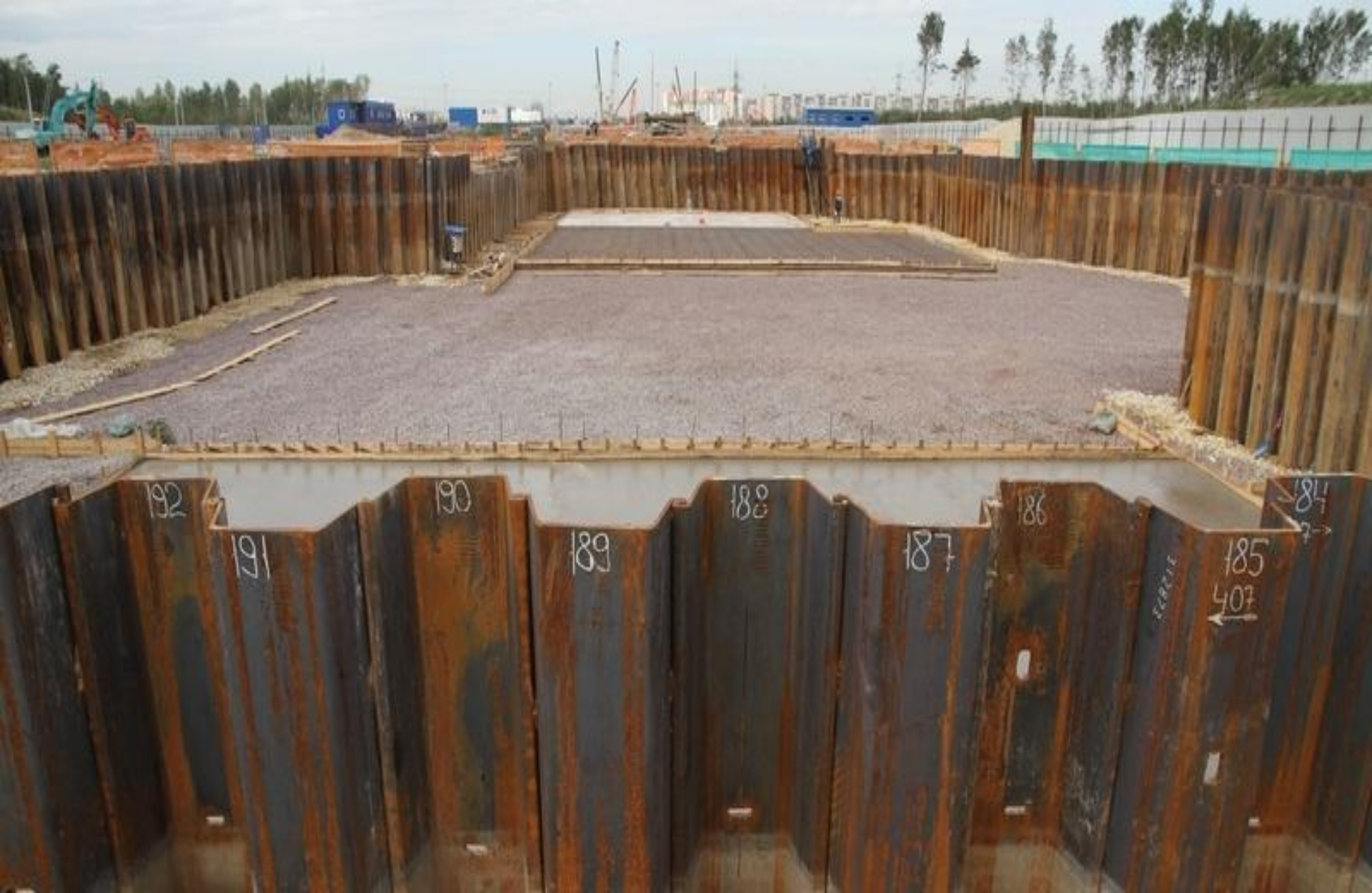
Извлекаемое закрепление стенок котлована из шпунта Ларсена
