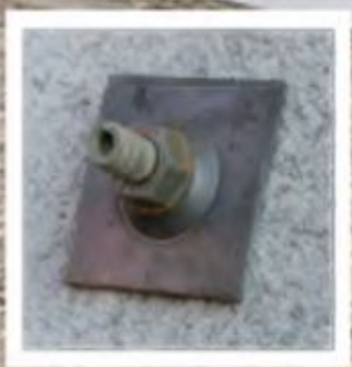
Головная конструкция для тонкретбетона
