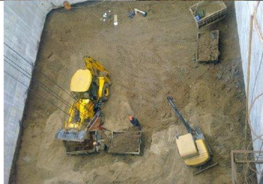
Разработка грунта внутри объекта
