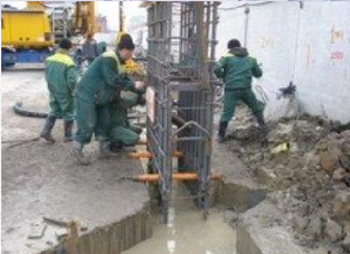
Монтаж пространственных арматурных каркасов
