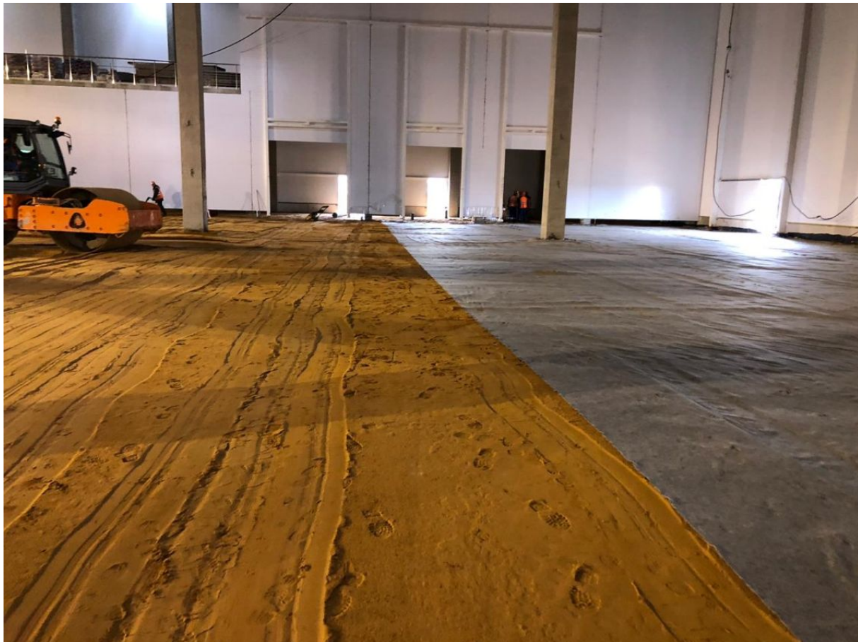
Устройство песчаного основания под плиту пола/ Making sand foundations for the floor slab
