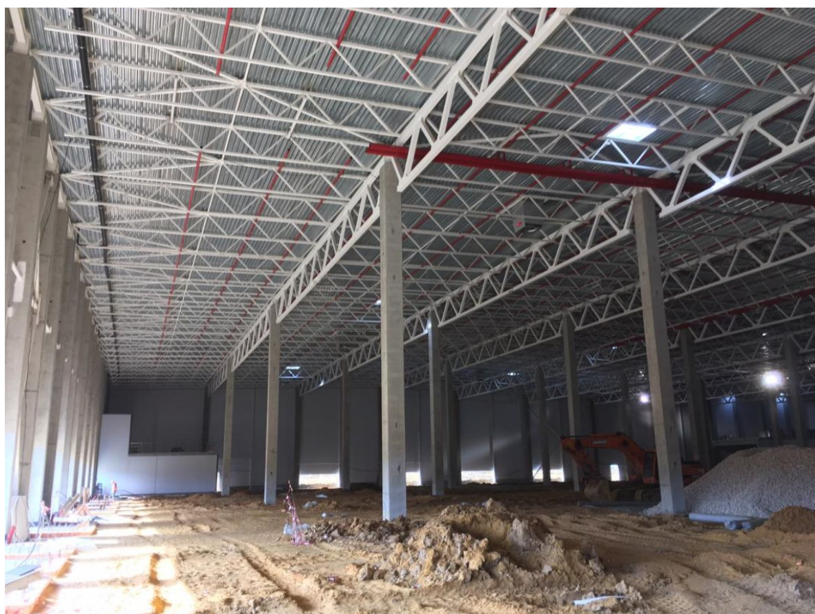
Монтаж системы водяного пожаротушения (спринклера) / Installation of water fire extinguishing system (sprinklers)
