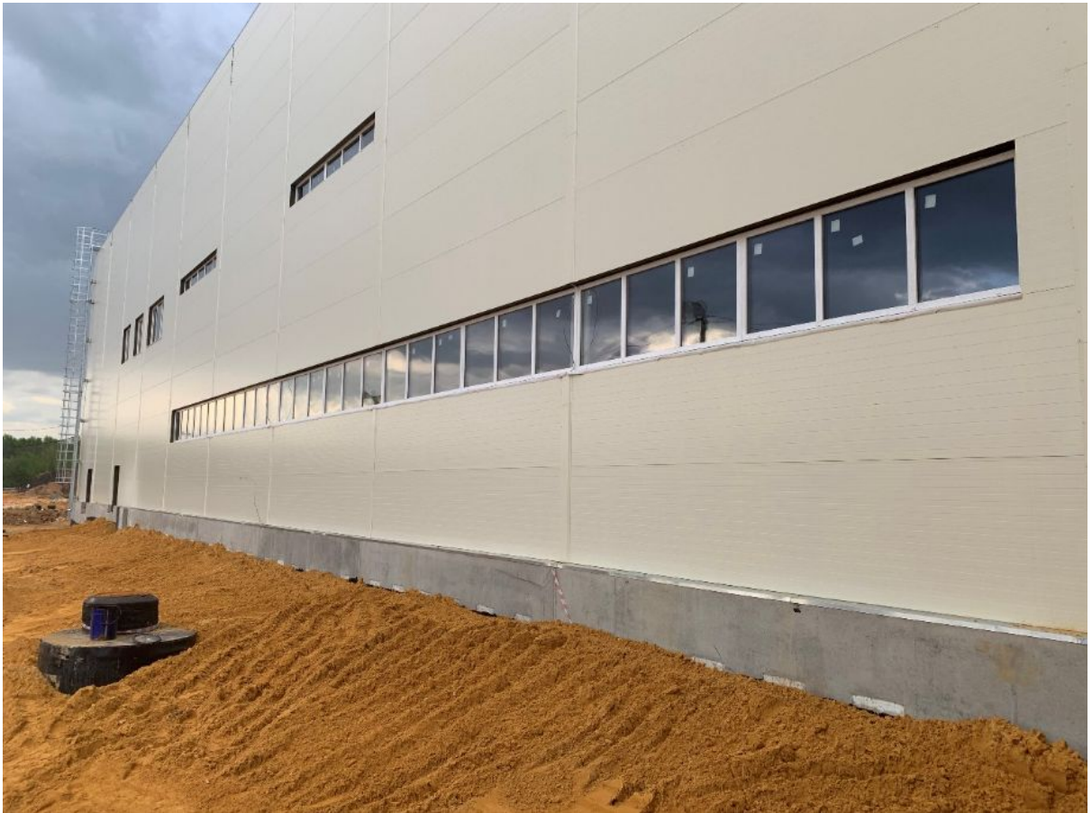
Обратная засыпка (система B2) / Backfilling (B2 system)
