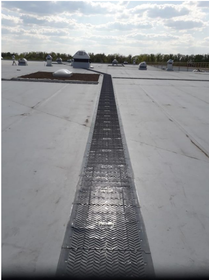
Монтаж кровельных дорожек / Installation of roof paths
