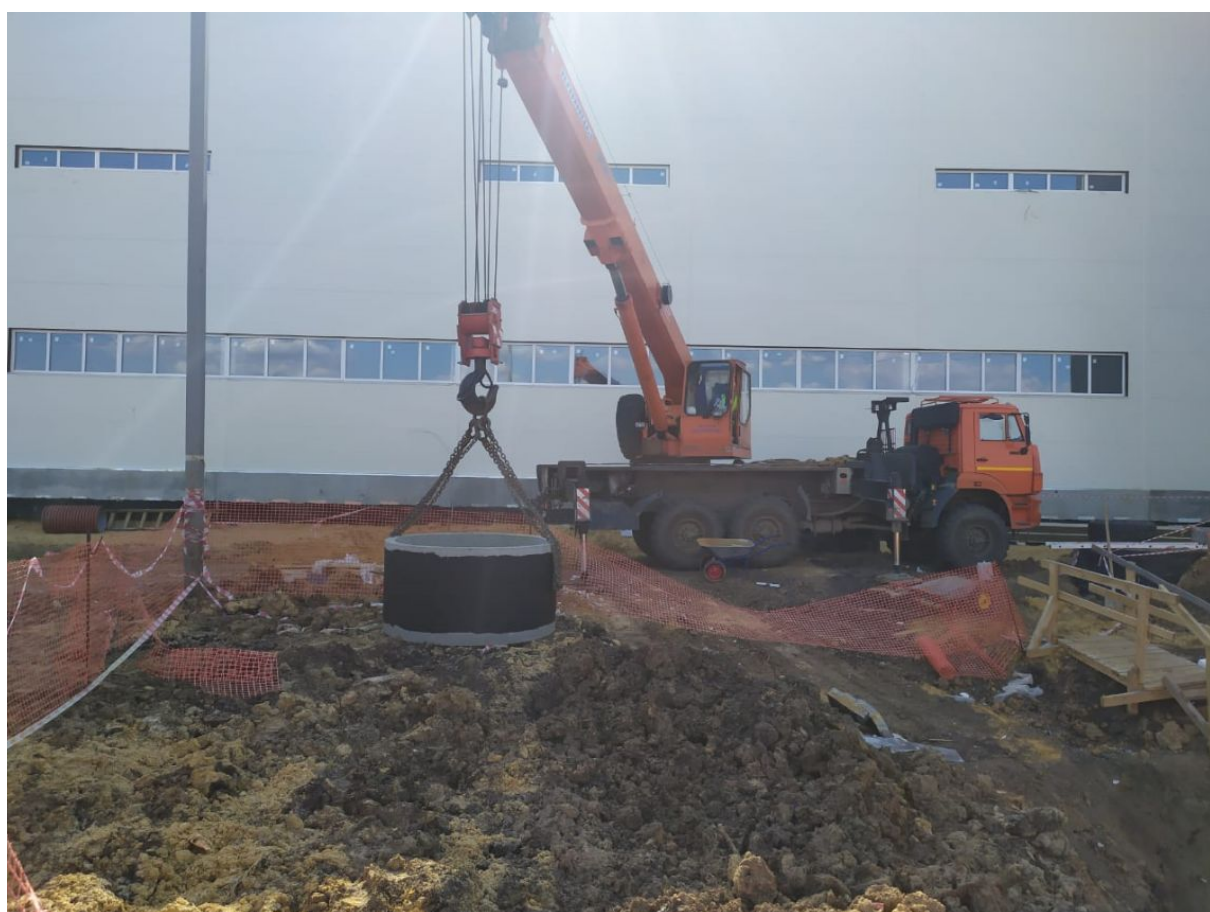
Устройство В2 / B2 installation
