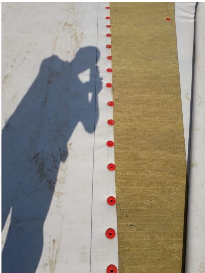
Монтаж пирога кровли / Installation of roof pie
