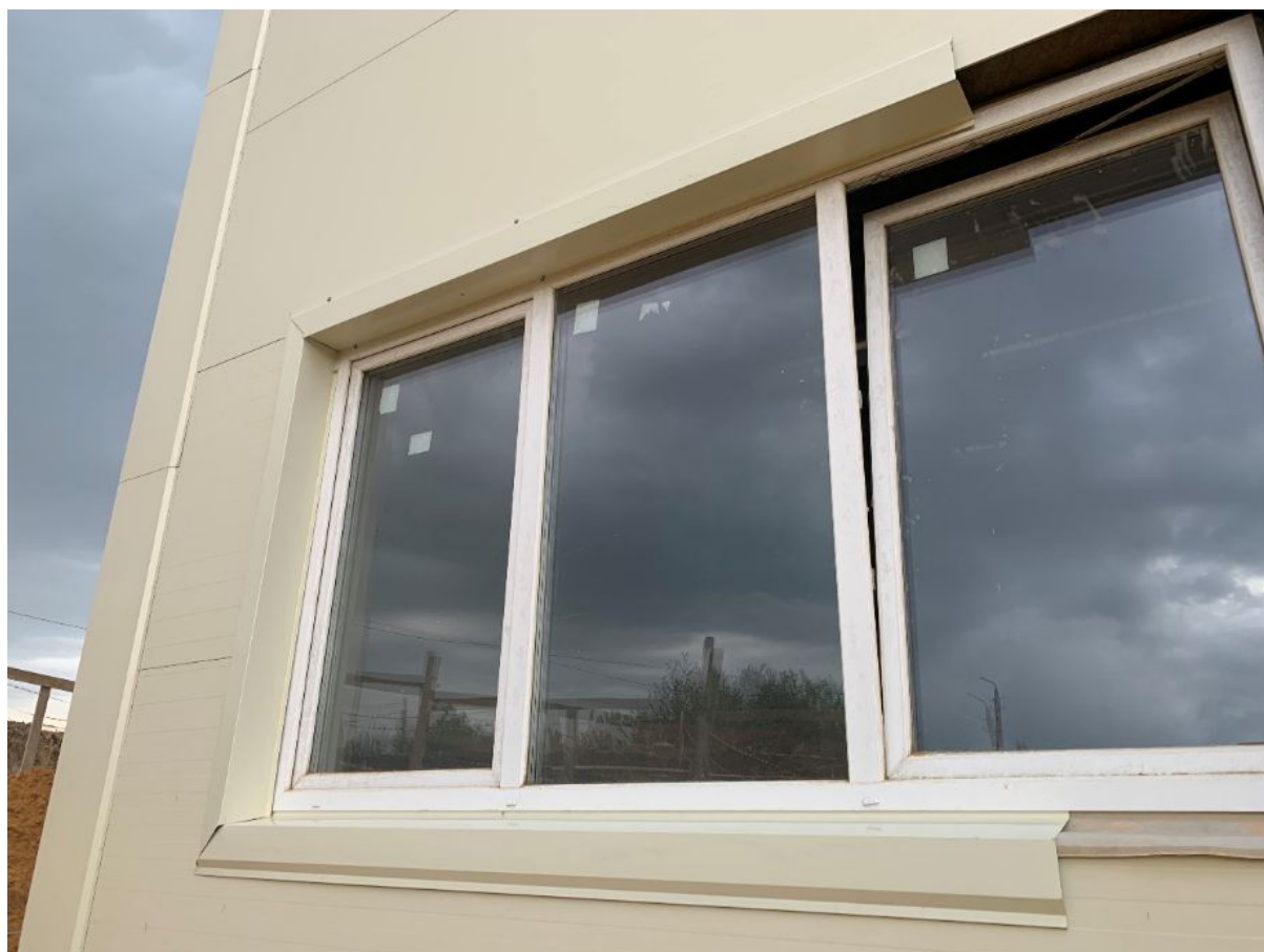
Монтаж окон малого АБК / Installation of windows in small ABK
