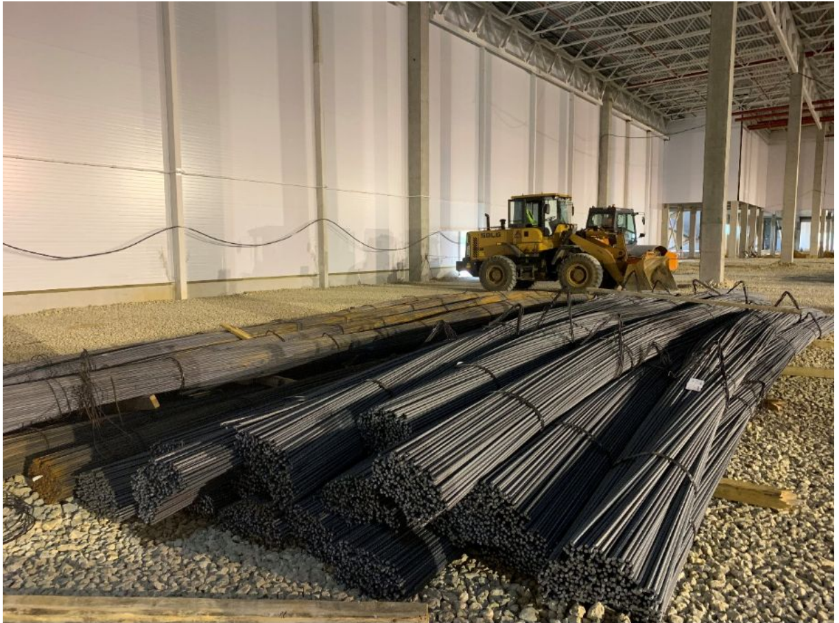
Подготовка к армированию плиты пола / Preparation for reinforcement of floor slabs
