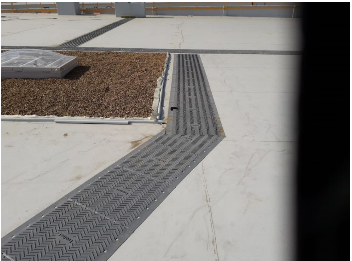
Монтаж кровельных дорожек / Installation of roof paths
