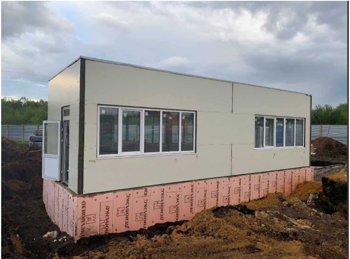
Строительство КПП / Installation of KPP (security check point)
