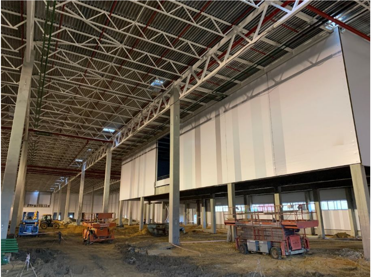
Монтаж внутренних сэндвич панелей / Installation of internal sandwich panels
