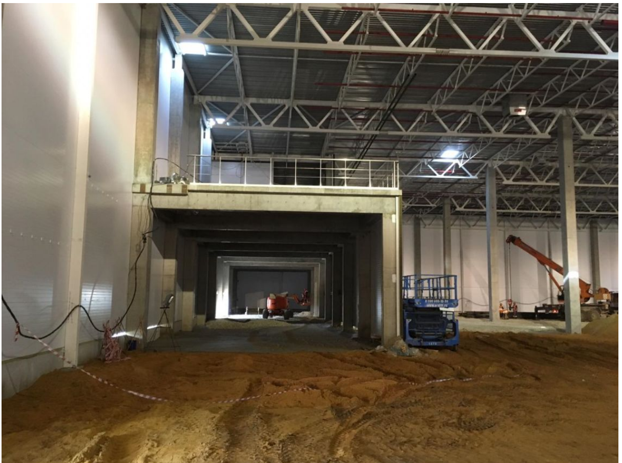
Монтаж системы водяного пожаротушения / Installation of water fire extinguishing system
