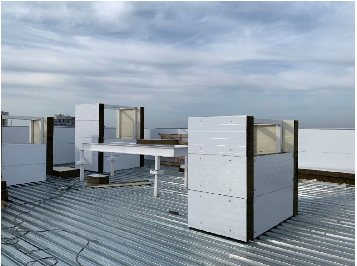
Монтаж стаканов под кровельное оборудование / Installation of glasses for roofing equipment
