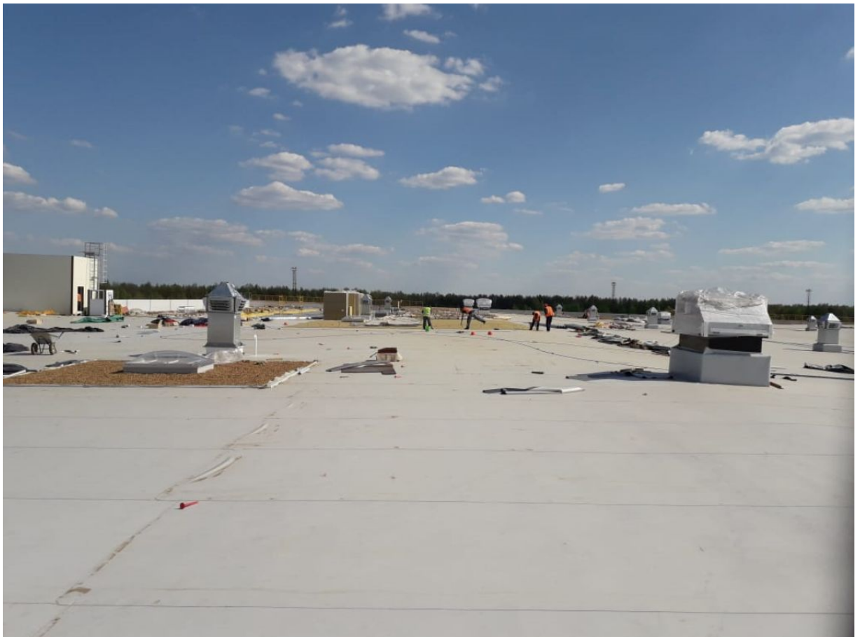
Монтаж пирога кровли / Installation of roof pie
