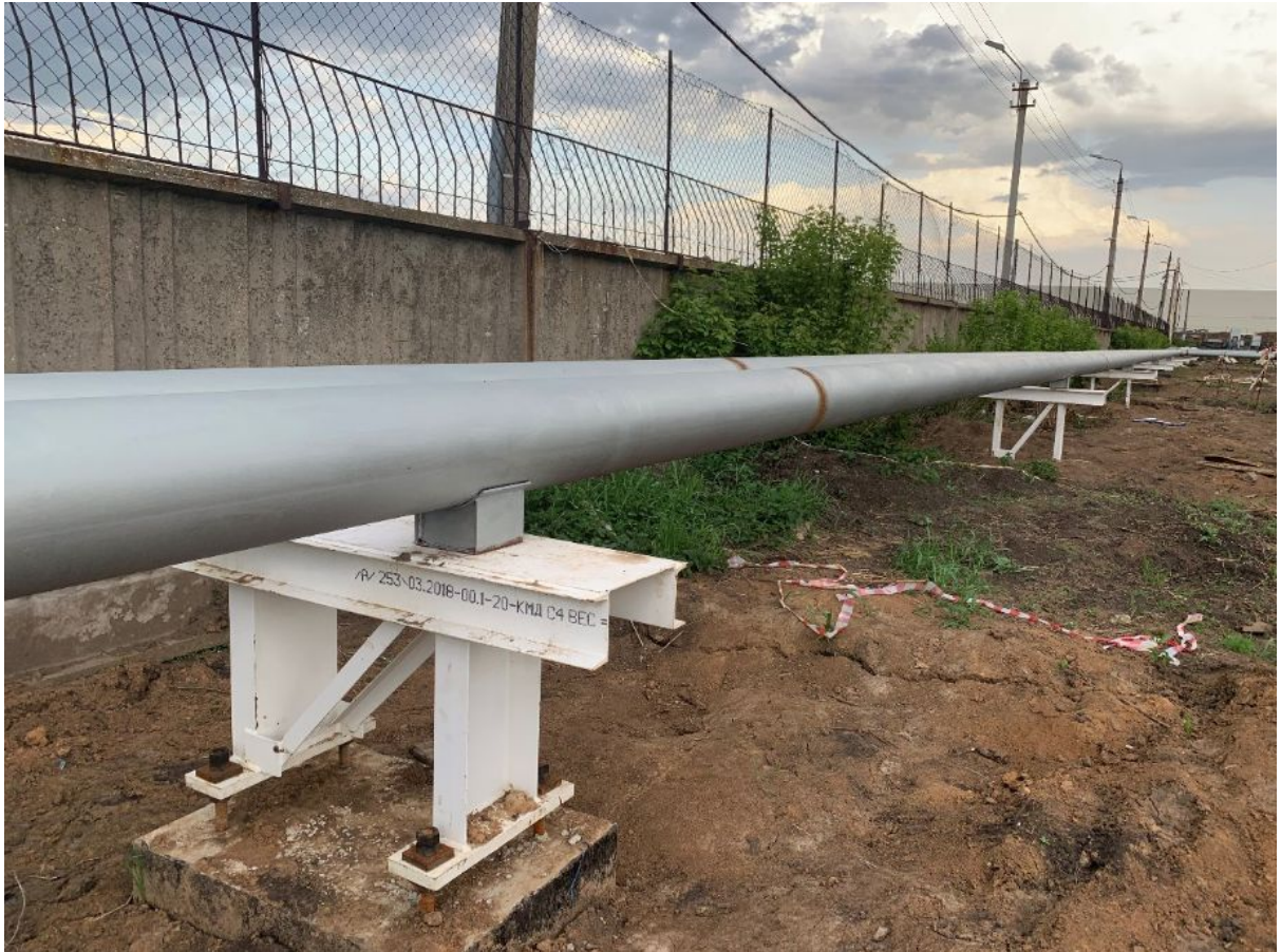
Монтаж теплотрассы / Heating pipes net installation
