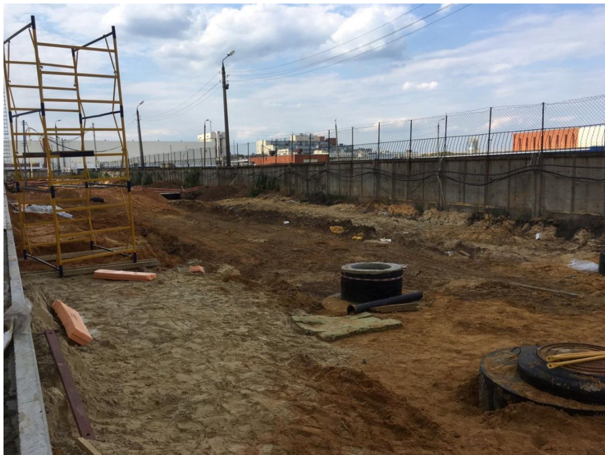
Устройство В2 / B2 installation
