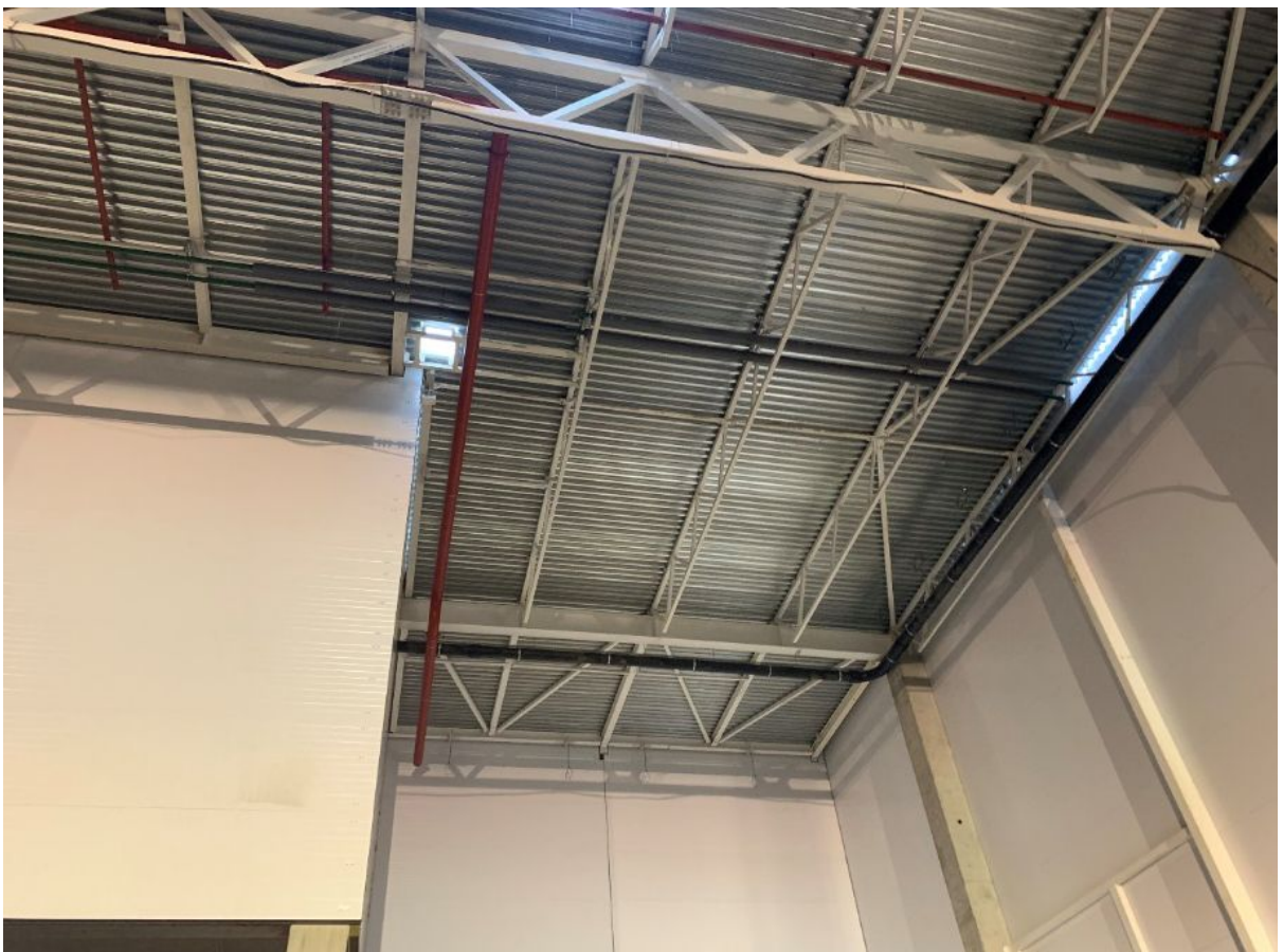
Монтаж внутренней ливневой канализации / Installation of the internal storm sewerage
