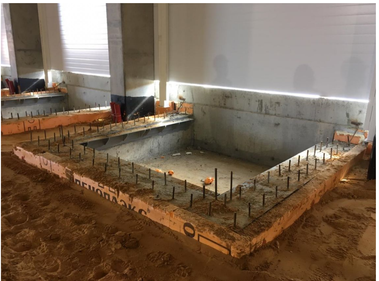
Разработка грунта под плиту пола / Excavation of soil under the floor slab
