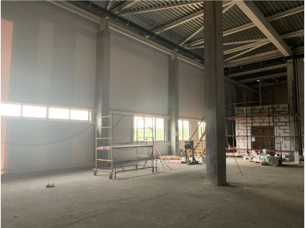
Монтаж стен из бетонных блоков / Installation of concrete block walls
