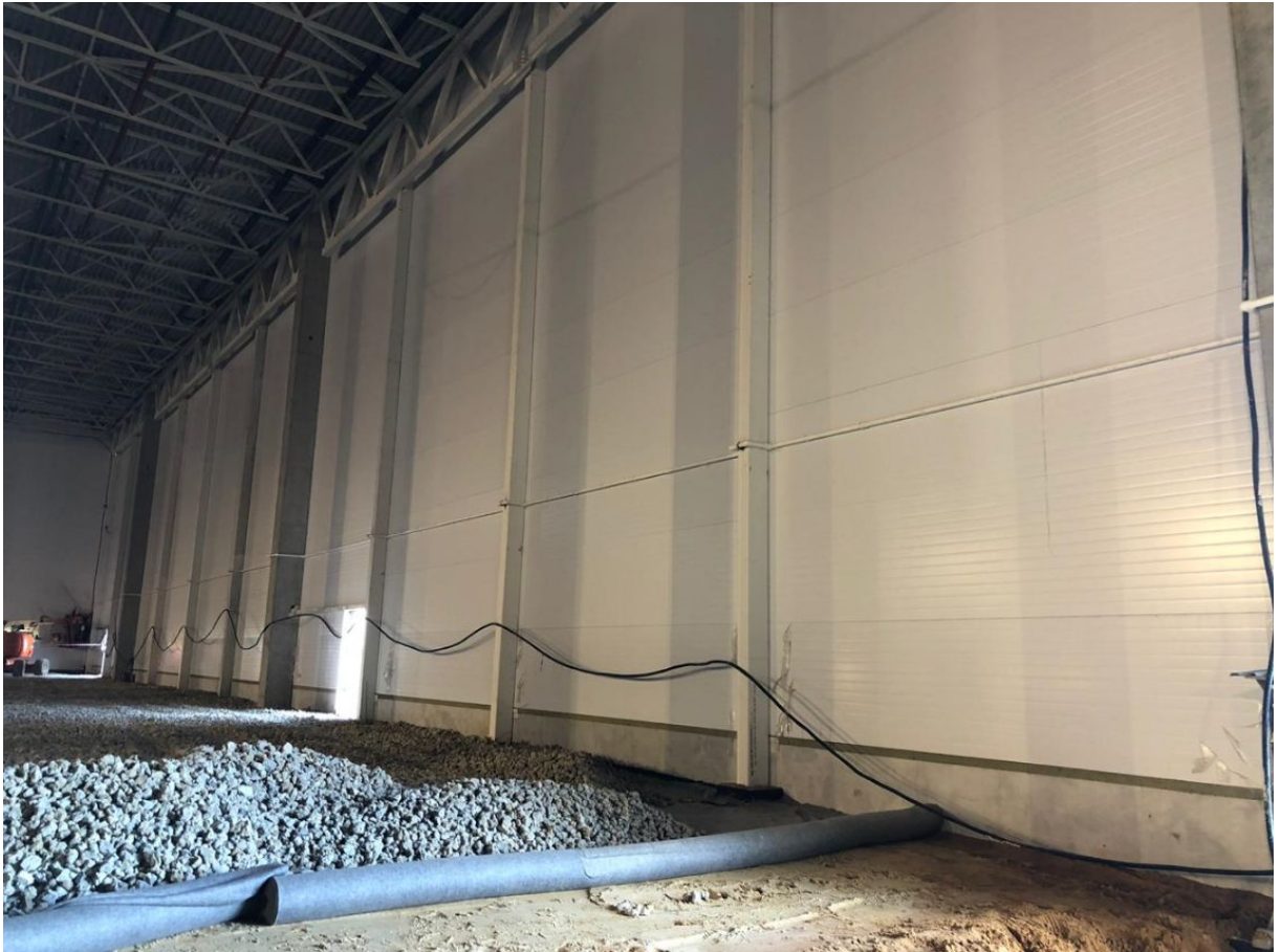
Устройство основания под плиту пола/ Making foundations for the floor slab
