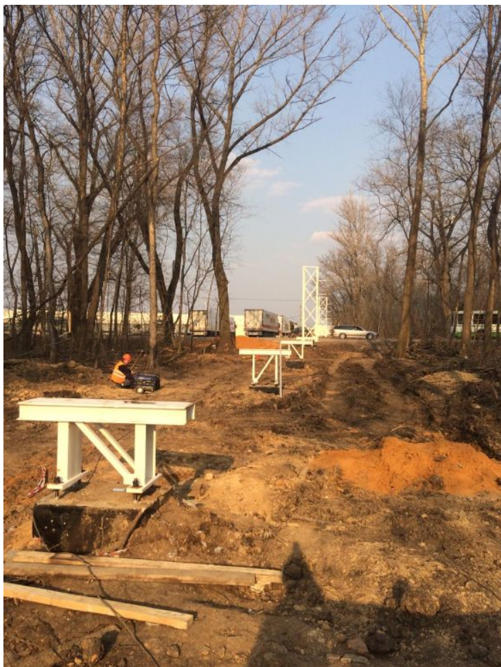
Монтаж теплотрассы / Heating pipes net installation
