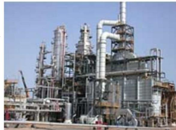
Рис.5. Установка вакуумной перегонки мощностью 1,5 млн. тонн в год на Туркменбашинском НПЗ по проекту фирмы Uhde.
