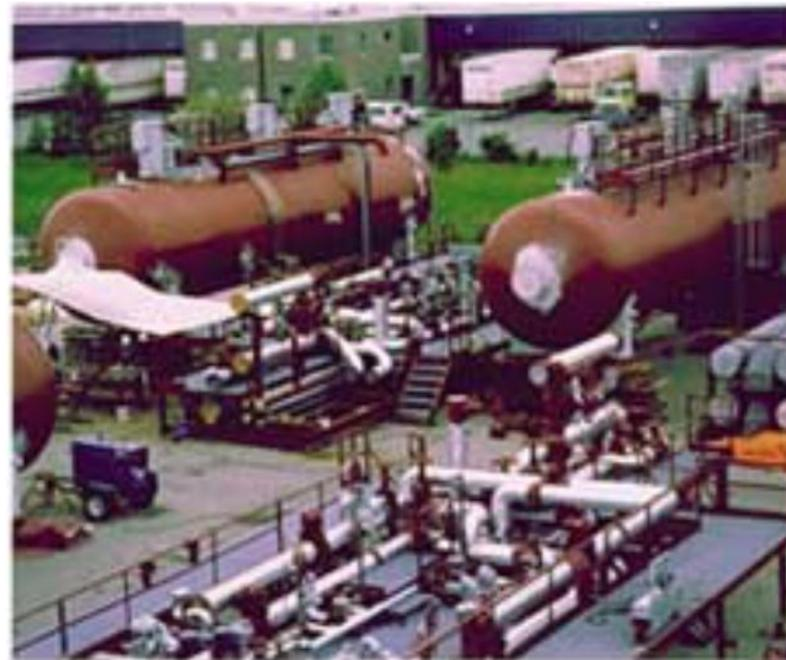
Рис.2. Электрообессоливающая установка фирмы Aker Kvaerner
