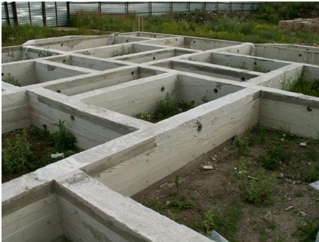
Ленточный фундамент 1,5 м. залегания
