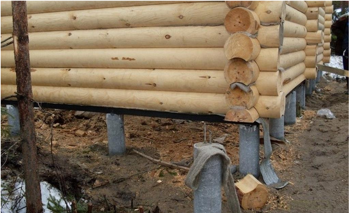
Буронабивные сваи \phi 300 \times 2500
