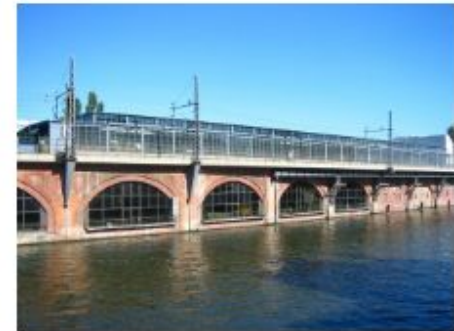
S-BAHNBÖGEN DER JANNOWITZBRÜCKE
