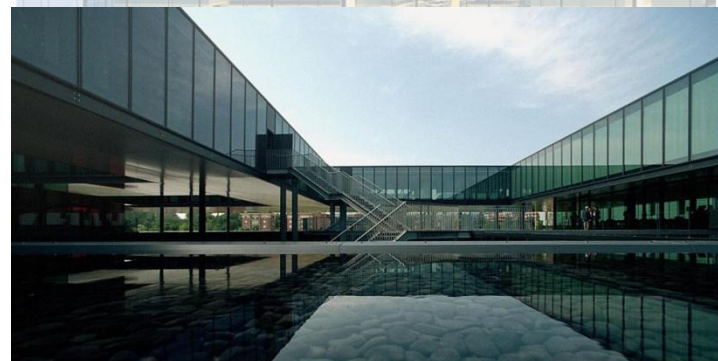
Исследовательский центр Феррари, арх. М. Fuksas
