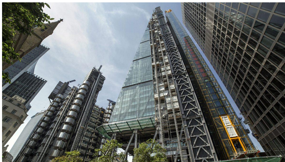
Здание на Лиденхолл стрит, арх. Р. Роджерс
