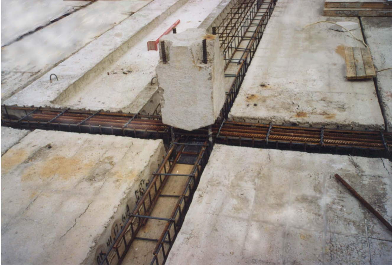
Узел сопряжения монолитных ригелей со сборной колонной
