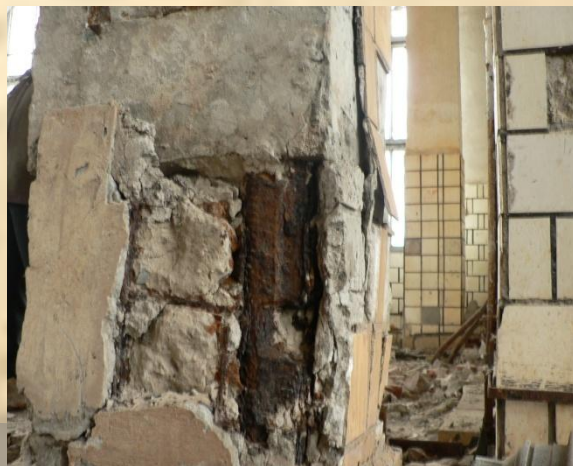
Колонна 2-го этажа
