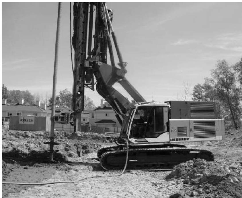
Буровая установка компании LIEBHERR (Германия)
