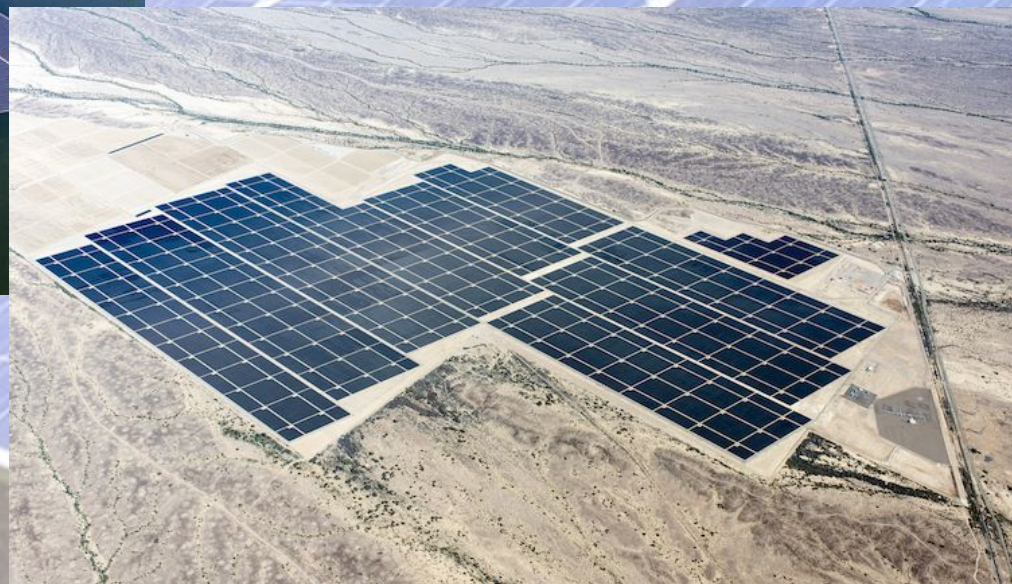
290 MW Agua Caliente Solar Project
