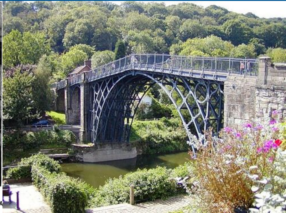
112. Чугунный арочный мост на р. Северн у Брозлея. Арх. Рейнольдс и Дерби, 1776—1779 гг. Пролет 30,6 м, стрелка 12,8 м
