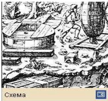
Старинная гравюра изображающая Механизм для проветривания шахт 15 век
