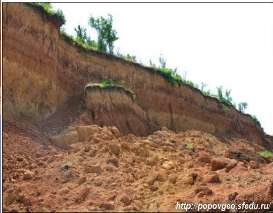
Оползневой склон на южном побережье Таганрогского залива. Чумбур-Коса.
