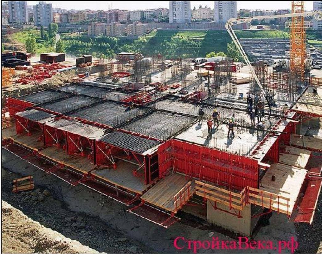
Представляет собой пространственный блок с «П»-образным поперечным сечением. Такая опалубочная система применяется в качестве опалубки стен и перекрытий при возведении зданий и сооружений жилого и общественного назначения.
