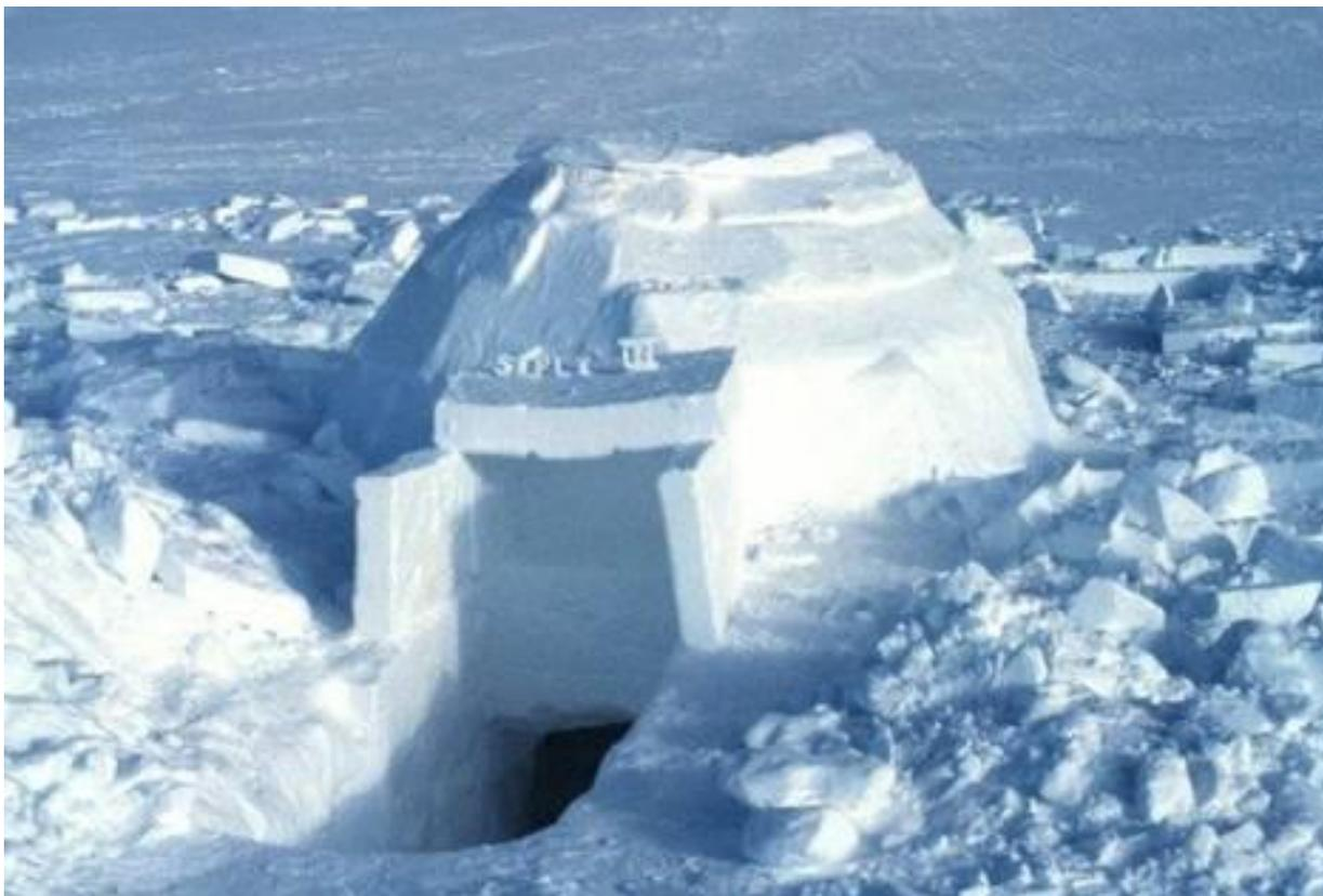
Иглу – так называется эскимосская хижина, построенная из снега. Это купол в человеческий рост, состоящий из снежных блоков и снабжённый низко пропиленной «дверью». Иглу, пожалуй, можно сравнить с копной сена, приспособленной под ночёвку.
