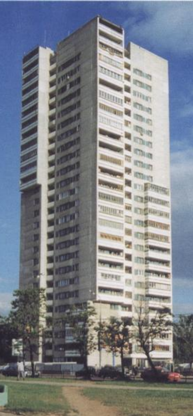
25-этажный каркаснопанельный жилой дом. Москва, просп. Маршала Жукова. Арх. Р.Сарухян.
