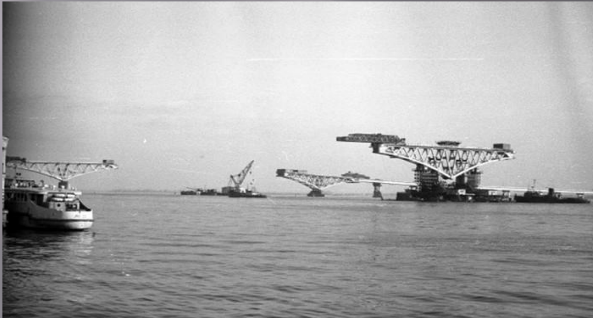
Строительство опор моста через реку Волга
