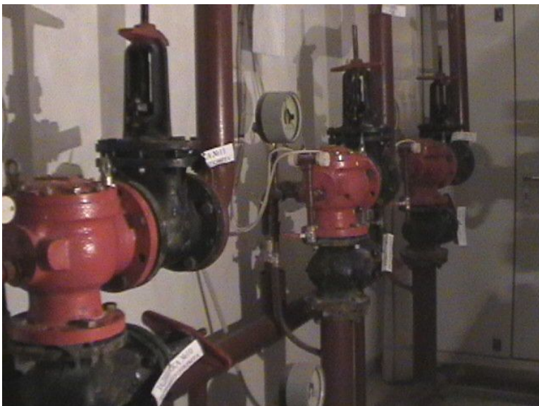
ГРЕБЁНКА (УЗЕЛ) СПРИНКЛЕРНОГО ПОЖАРОТУШЕНИЯ
