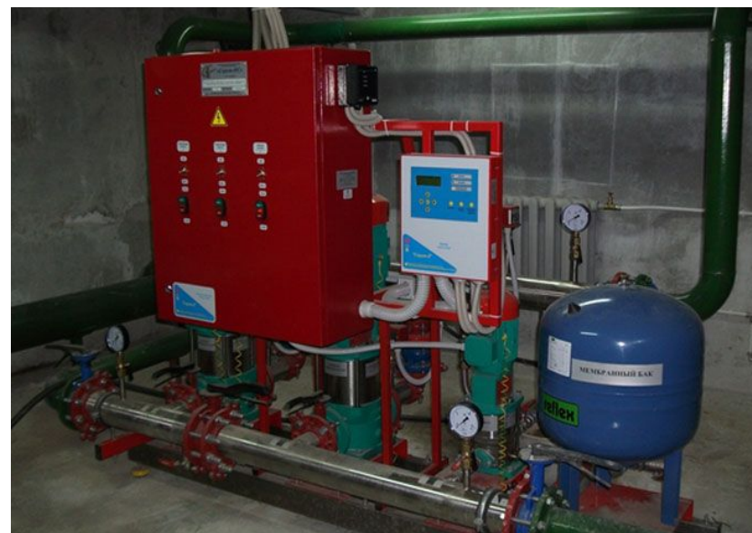
НАСОСНАЯ СТАНЦИЯ ПОЖАРОТУШЕНИЯ
