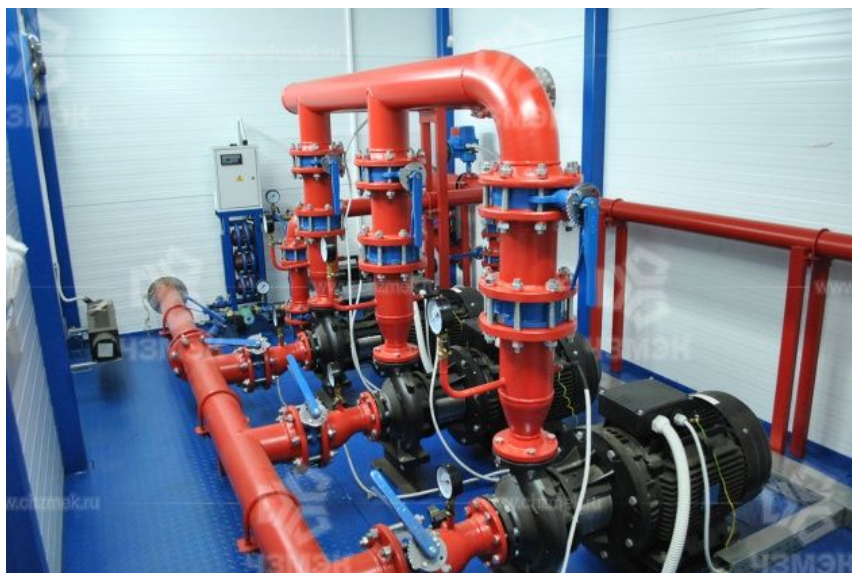
НАСОСНАЯ СТАНЦИЯ ПОЖАРОТУШЕНИЯ
