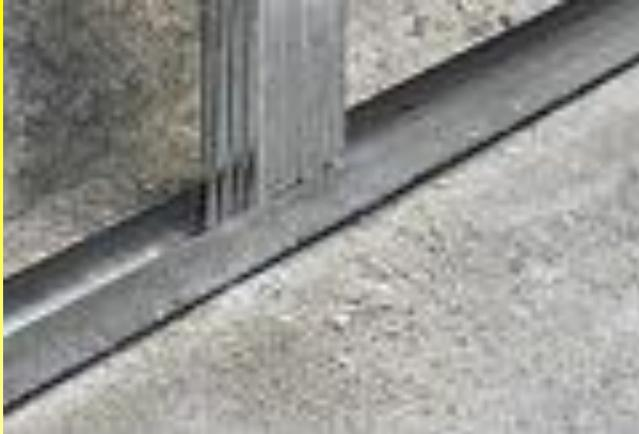
10. В направляющие профили на полу и потолке вставьте (поочередно) стоечные профили, проверяя вертикальность с помощью уровня.
