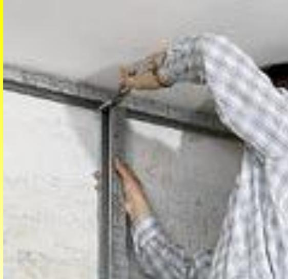
11. Винтами-саморезами (или заклепками) соедините направляющие профили на потолке и полу со стойками.
