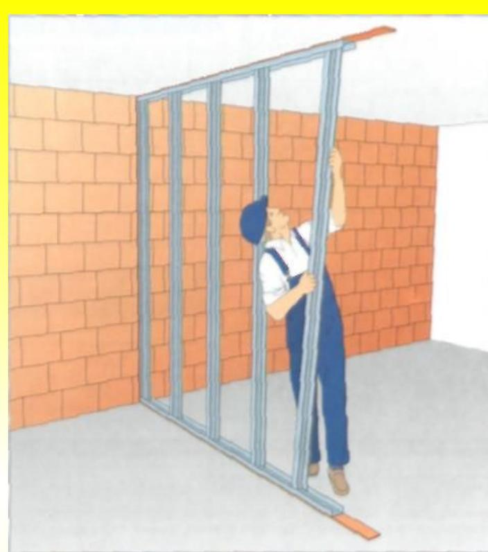
**3. Монтаж стоек.** Профили-стойки вставляют в нижний, затем в верхний профили с шагом 600 мм. Стойка должна входить в направляющую на потолке минимум на 20 мм.
