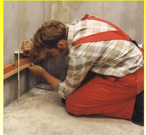
Начинают от обозначенной на стене горизонтальной линии и прикрепления в этом месте деревянной или алюминиевой рейки. Рейка определяет уровень от которого начинают укладку плиток.
