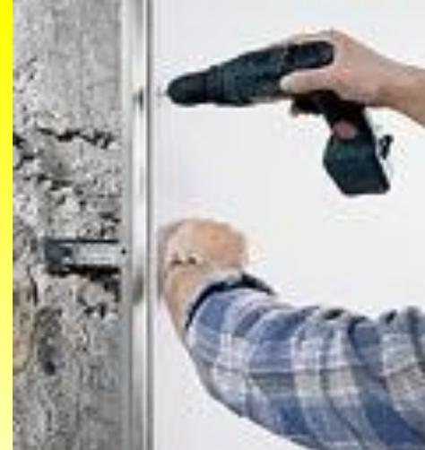
12. К несущей конструкции из металлических профилей прикрепите самонарезающими шурупами листы гипсокартона так, чтобы стык находился посередине "подошвы" профиля. Шаг крепления - около 250 мм.
