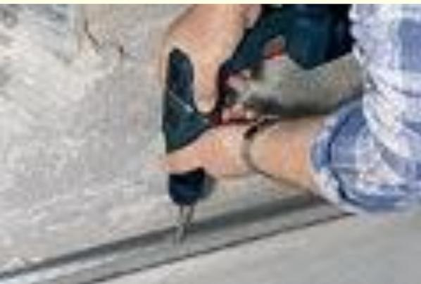
7. Закрепив временно направляющие профили вдоль линии разметки на полу, сделайте в нем с помощью твердосплавного сверла отверстия под дюбели.
