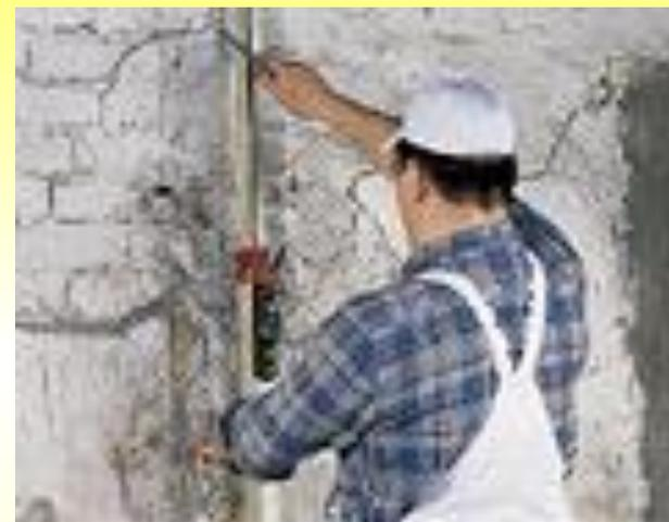
3. Разметьте линии расположения вертикальных стоечных профилей и места их крепления (с шагом 600 мм).
