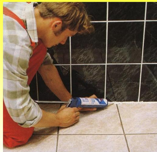
Соединение между стеной и полом силиконовой массой
