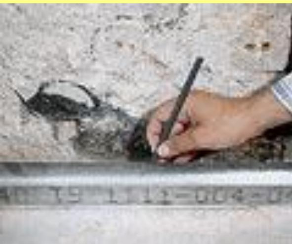
1. На полу разметьте линии расположения направляющих профилей.
