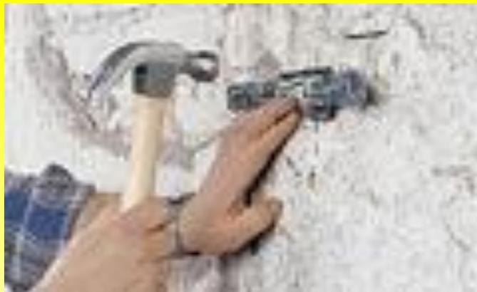
5. После этого прикрепите к стене прямые подвесы (стальные пластины) с помощью дюбелей и шурупов.
