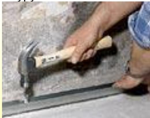
8. Прикрепите к полу направляющие профили с помощью дюбелей и шурупов.
