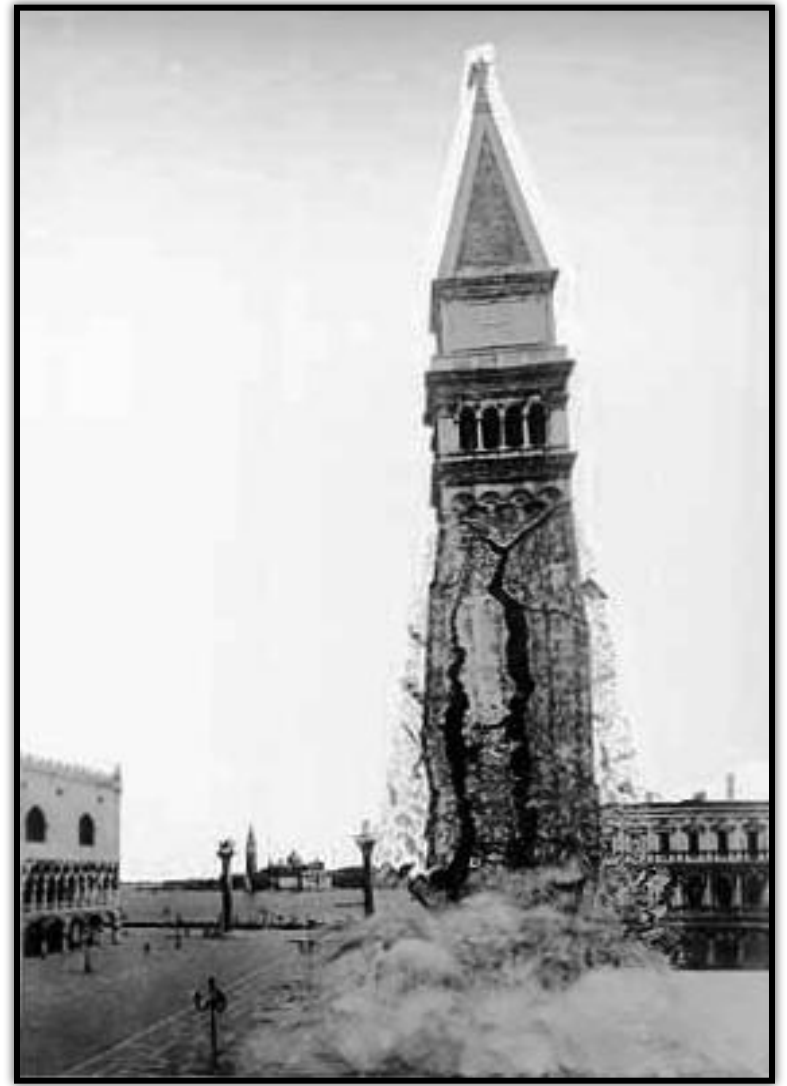
Падение колокольни собора св. Марка в Венеции, вызванное разрушением грунтов основания
