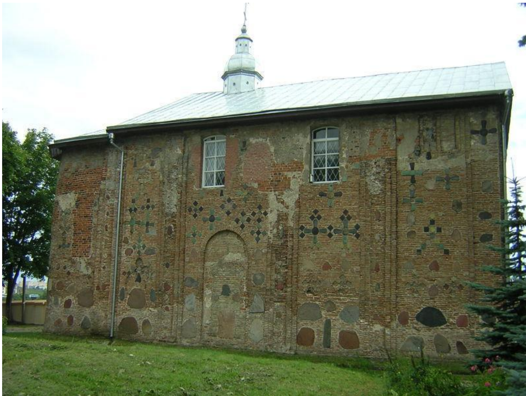
Борисоглебская (Коложская) церковь в Гродно. Северный фасад
