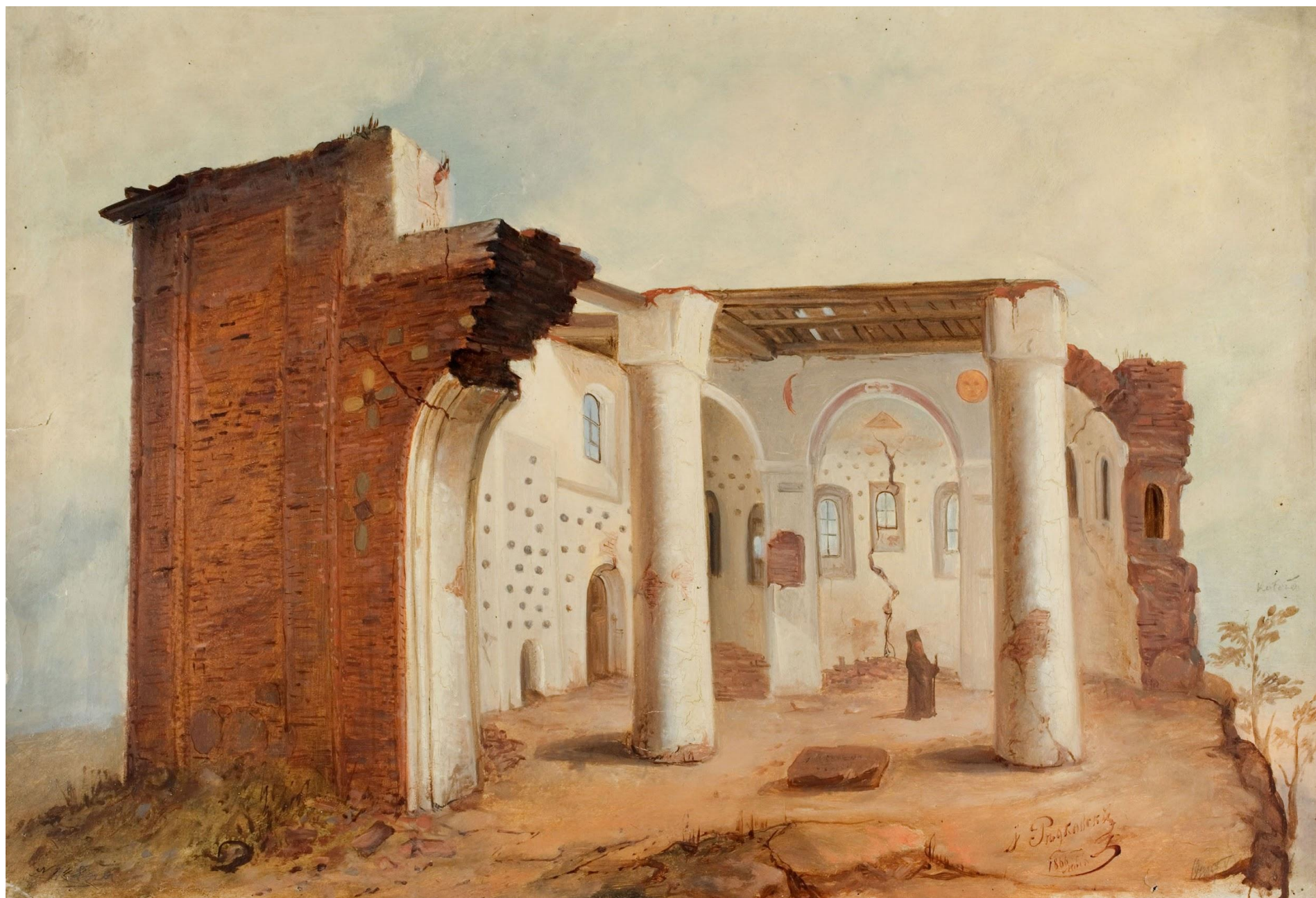
Борисоглебская (Коложская) церковь в Гродно после обрушения. Вид с запада. Акварель 1866 г.
