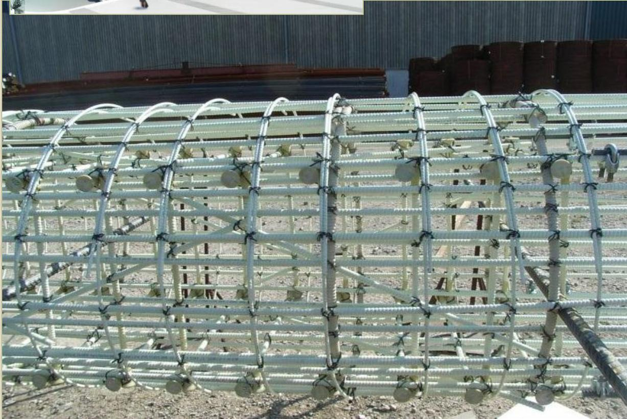
Стены нижних этажей и буронабивные сваи выполнены без применения стали во избежание возникновения индукционных токов от прилегающего тоннеля метро
