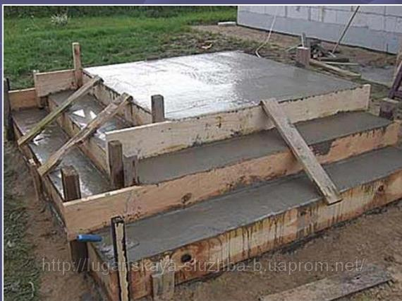
Свежеуложенная бетонная смесь оказывает гидростатическое давление на стенки опалубки.
