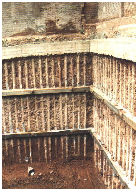
Устройство ограждений из буровых свай
