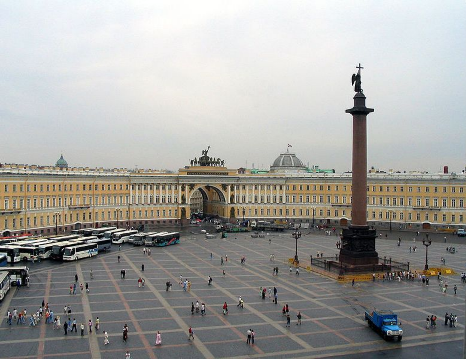
Здание Главного штаба на Дворцовой площади
