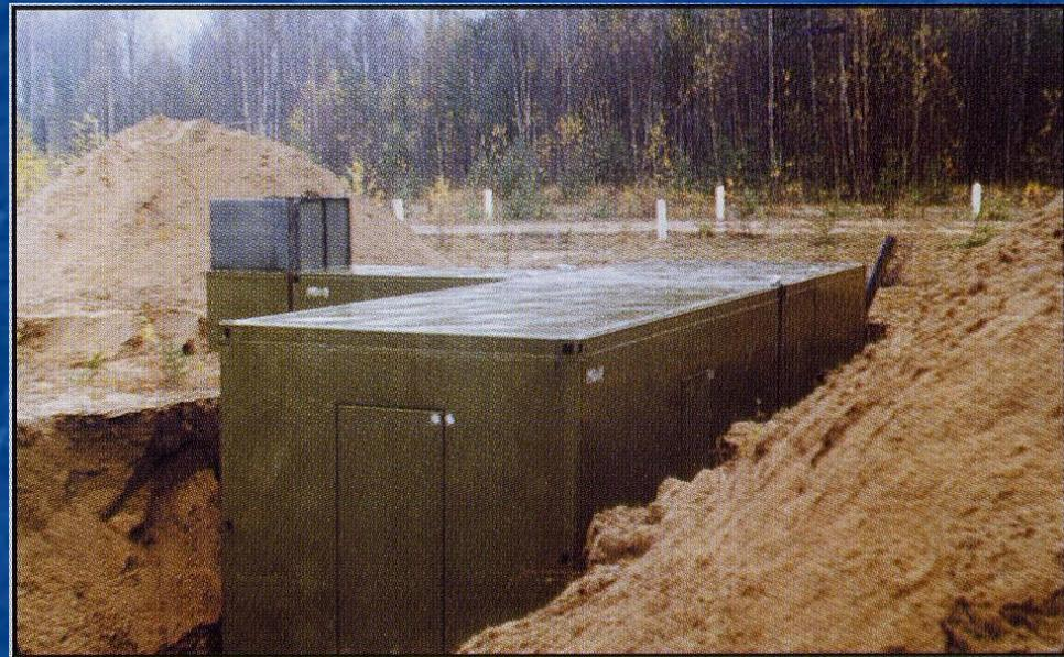
**Модули-блоки конструктивно выполнены в виде параллелепипедов из стального проката по рамно-панельной схеме.**
