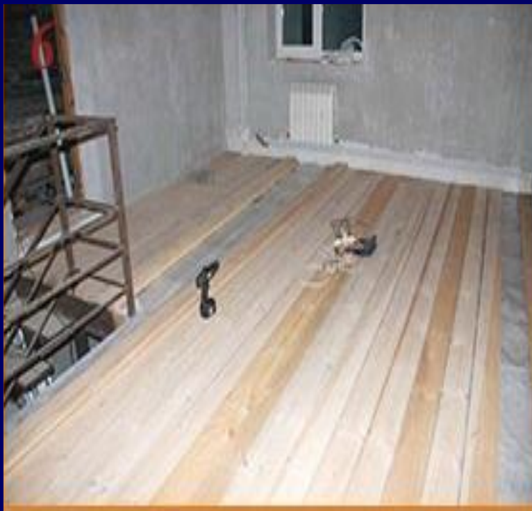
б. Крепление досок пола по балкам
