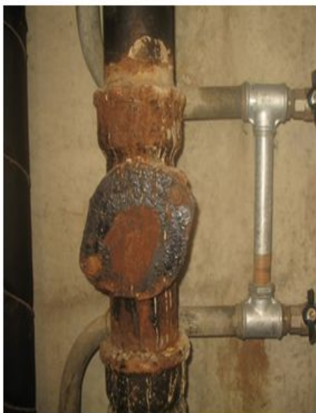
Видны протечки стояка канализации.
