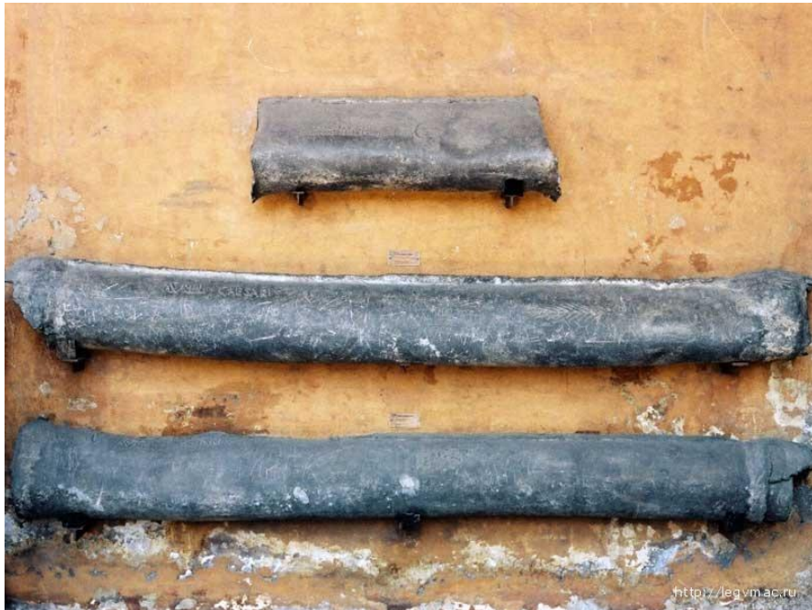
свинцовые трубы римского водопровода
