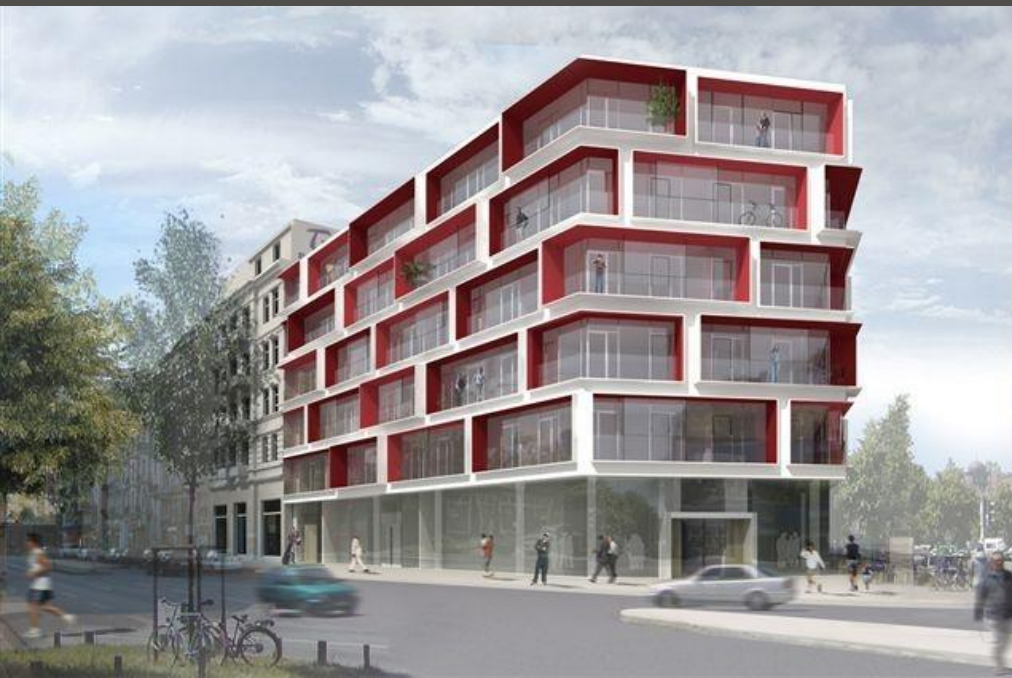
Altonaer Str. Hamburg Architect: SEHW Architekten.
