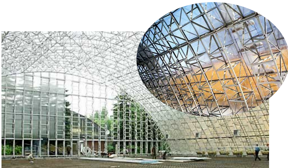
Арочное здание из алюминиевых объемных решетчатых арок
