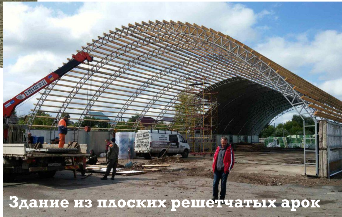
Арочное здание из алюминиевых объемных решетчатых арок
