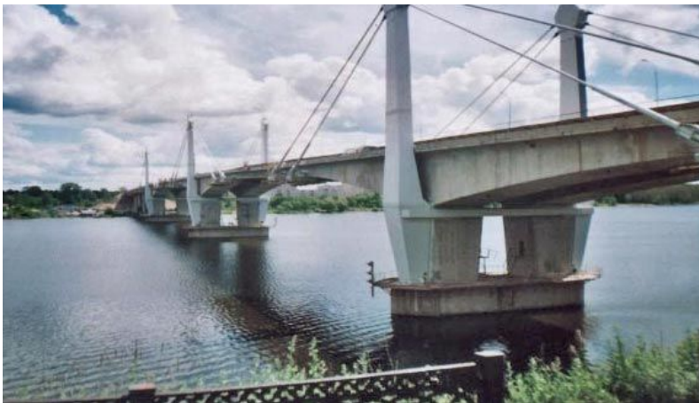
Мост через р.Волга в г.Кимры
