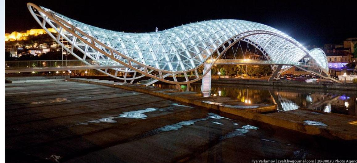
Мост состоит из 156-метрового стального каркаса, покрытого стеклом. Вся конструкция опирается на 4 мощных опоры
