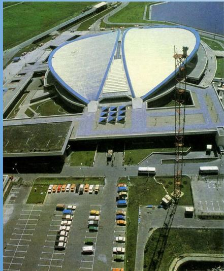
Пролёт велотрека длиной 168 метров перекрыт двумя парами наклонных арок, соединённых мембраной из рулонной стали толщиной 4 мм
