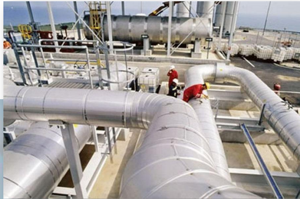
Сооружение трубопровода пара и горячей воды
