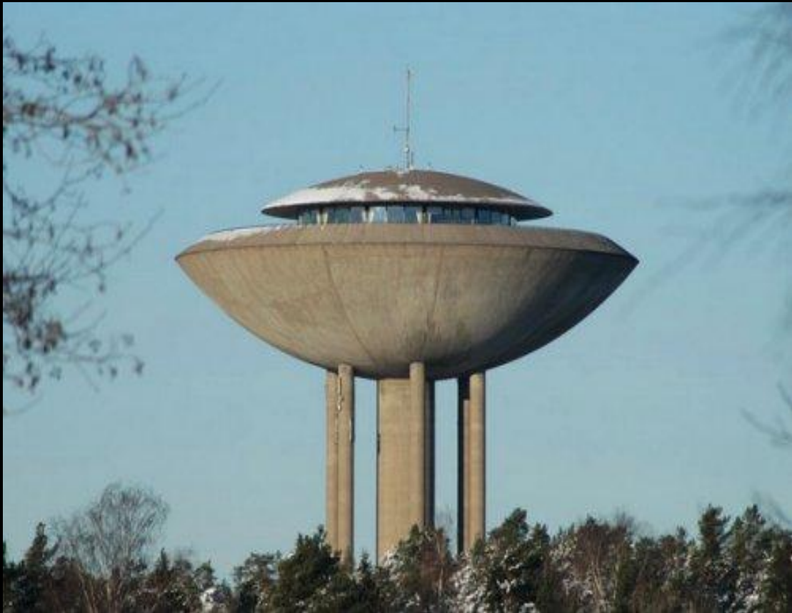
Водонапорная башня города Хаукилахти, Финляндия
