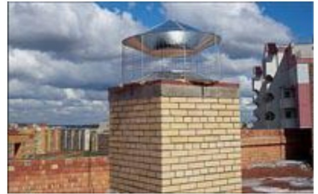
Рисунок 3. Дефлектор ДС710 в г. Жуковский (12 шт. на одной кровле)
