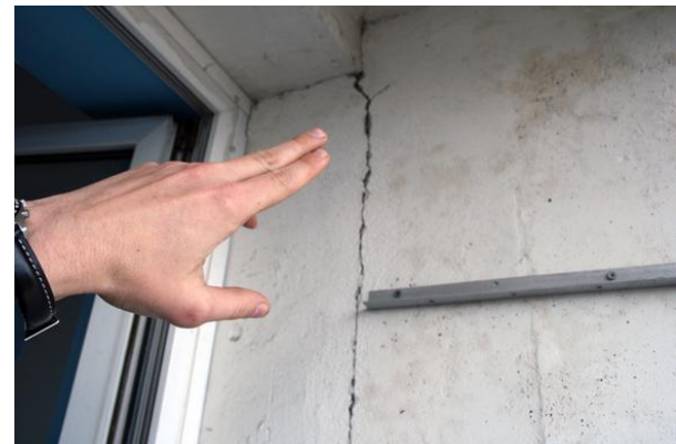
Пример усадки панельного дома
