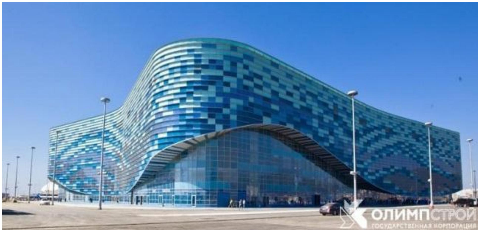
Основная несущая конструкция покрытия – купол. Покрытие состоит из центрального ядра весом более 200 тонн и 36 лучевых ферм. Общий вес покрытия составил более 1900 тонн.
