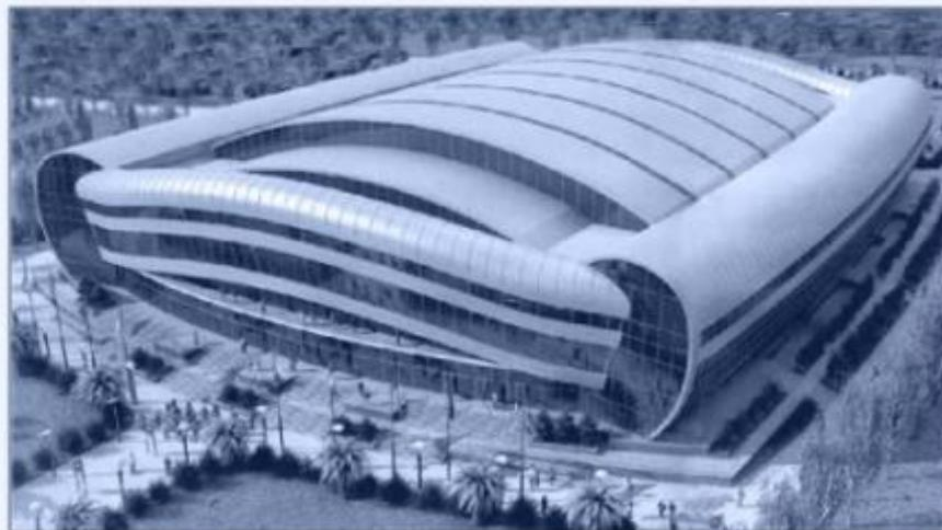
Сборно-разборное здание арены для кёрлинга выполнено с применением рамных конструкций переменного сечения. Все конструкции каркаса опираются на монолитную фундаментную плиту в виде вогнутого прямоугольника, воспринимающего вертикальные и горизонтальные нагрузки от распора рам и сейсмических воздействий.
