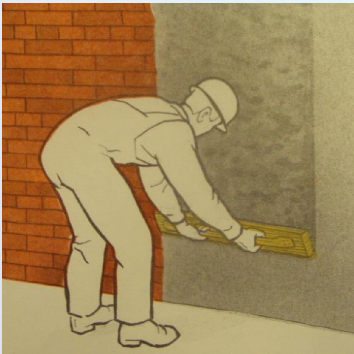
Разравнивание грунта
