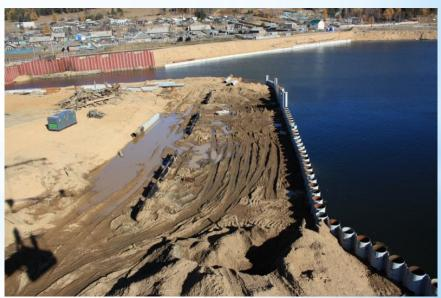
Трубчатый шпунт (трубошпунт) изготавливается из цельной стальной трубы путем приварки к ней замковых элементов различных конструкций.
